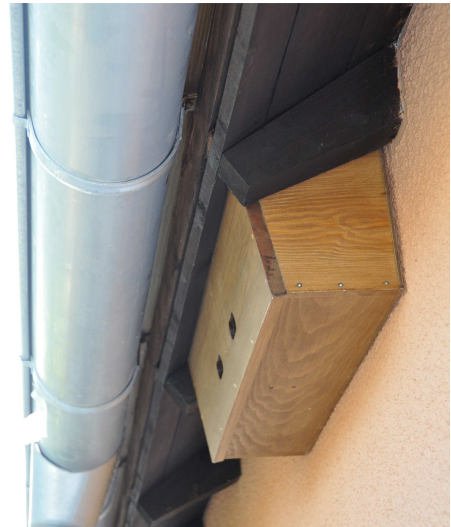
Abb.3: S. Maurer-Wohlitz „Nistkasten-Konstruktion für Mauersegler zwischen Balkenköpfen unter der Traufe – in Kastenform“
