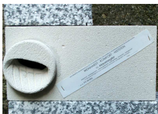
Foto 4: S. Maurer-Wohltatz "Einbaustein aus Porenbeton"
